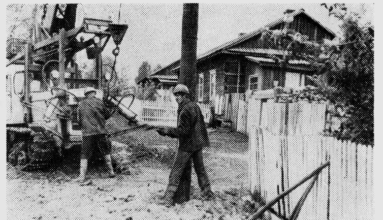
НА СНИМКЕ: бойцы стройотряда «Энергия» летом на трассе. Фото А. Шереметьева.
